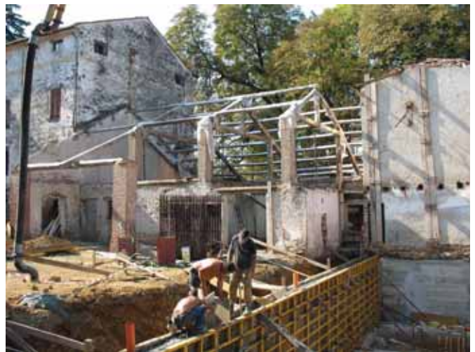
Una fase dei lavori di villa Ca' Dotta.
